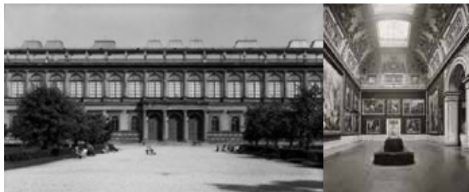
Das Gebäude von Süden in einer Aufnahme von 1938 und der Rubenssaal 1926 (von links)
