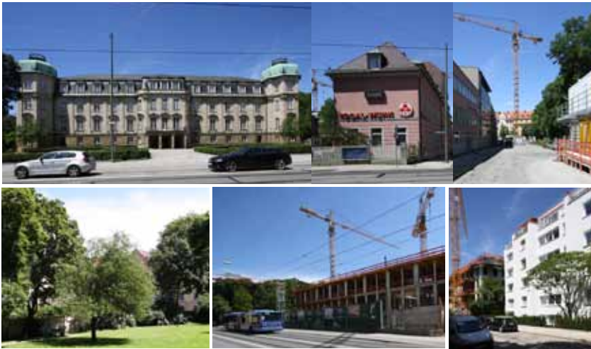
Der Bundesfinanzhof im Künstlerhaus Fleischer, Togonal-Werk, die Baustelle Montgelas Park und der Bürgermeisterpark (von oben im Uhrzeigersinn)
