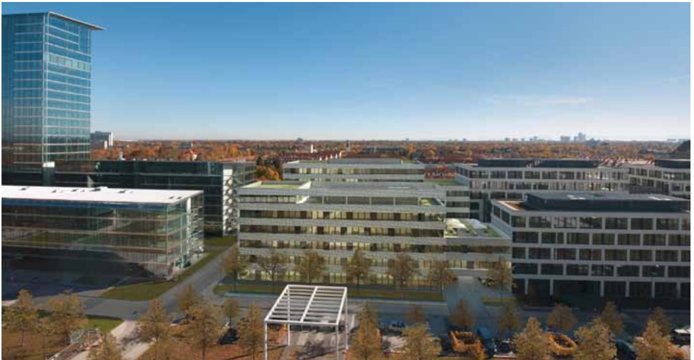
Das Bürogebäude Platineum (Bildmitte) neben dem Hochhaus m.pire wird eine der letzten Baulücken schließen
