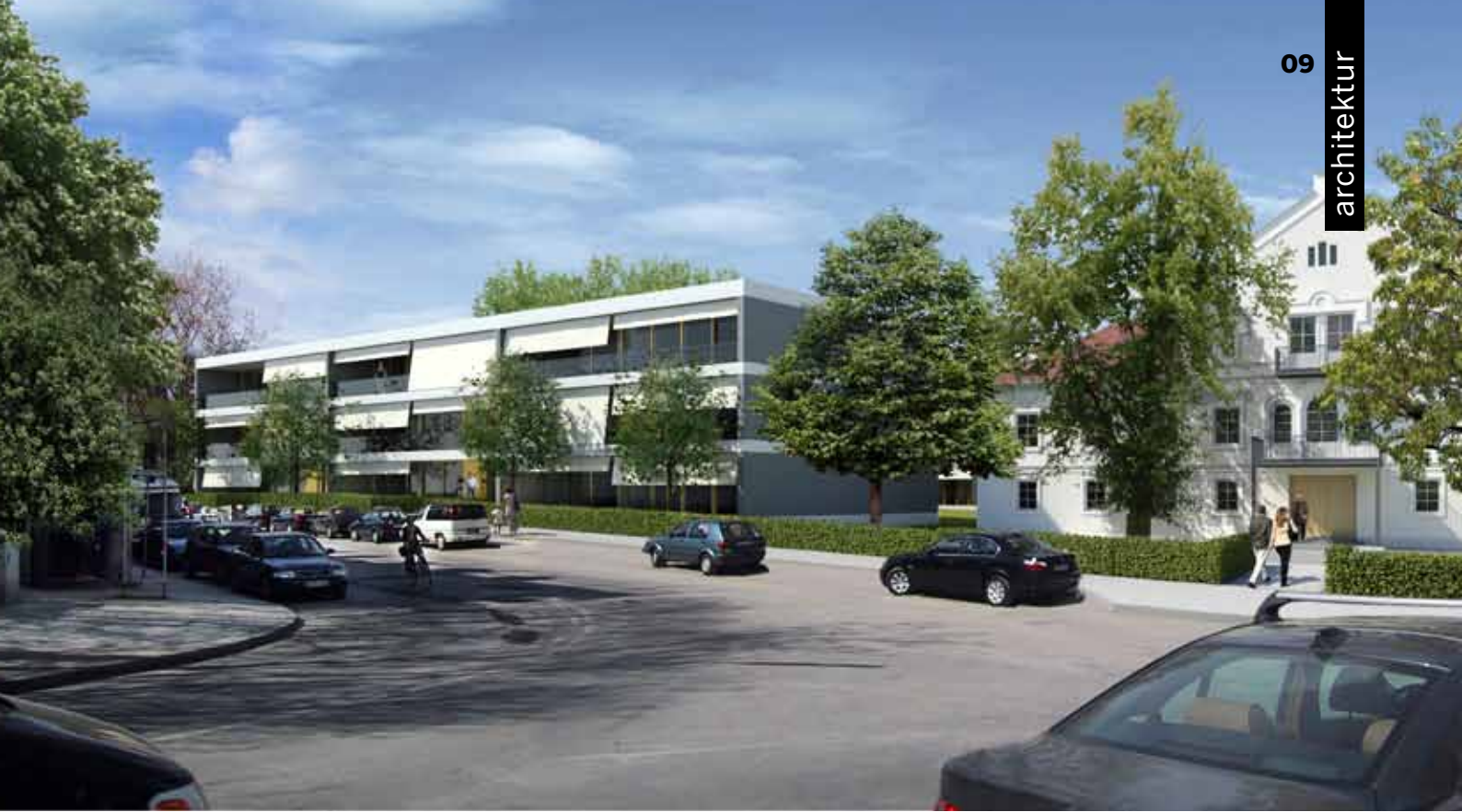
Das neue Gebäude (links) neben der Thiersch-Villa in Schwabings Maria-Josepha-Straße
